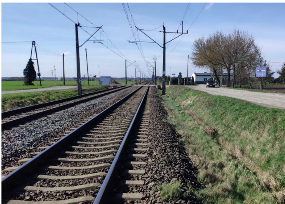
Zdjęcie 1 Widok z toru nr 1, widoczne rowy boczne i drogi równoległe do toru
